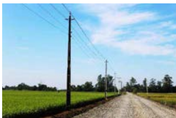
Localidade de Jacaré – Meleiro
